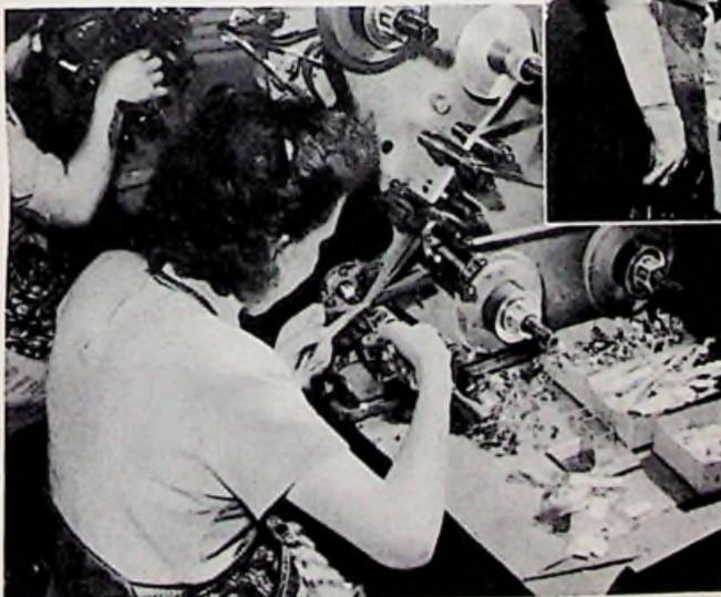
Bild 5. Wickeln von Rollkondensatoren
