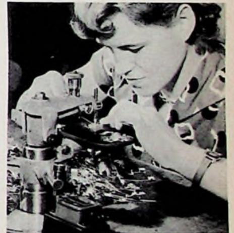
Bild 4. Anschweißen der Anschlußdrähte an die Kontaktfahnen
